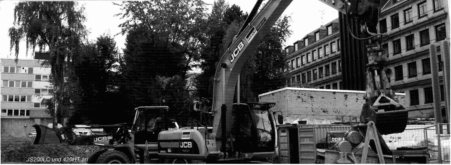
JCB 426HT beim Einsatz in der Baugrube des Kölner Stadtarchivs
